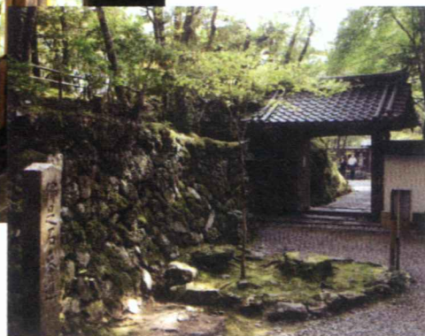
石水院の入口の門
