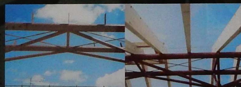
鉄骨のキール
