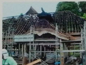
茅撤去後の式台部分
