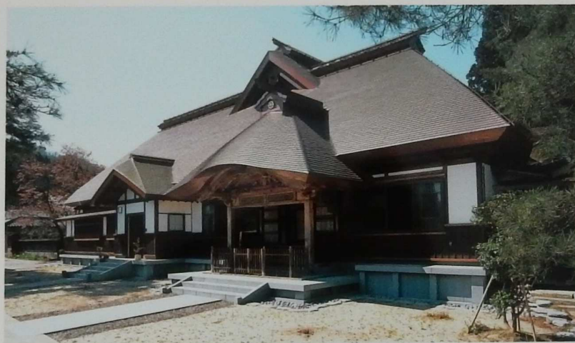
茅屋根の形状を踏襲した改築後の外観
