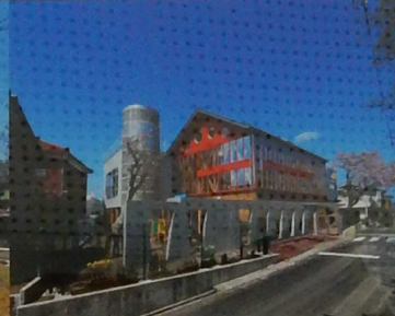
南東より見る
