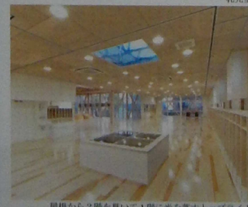
屋根から2階を貫いて1階に光を落とすトップライト
