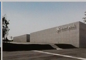
北側外観 近隣住宅に配慮した開口部を設けないアプローチ側外観
