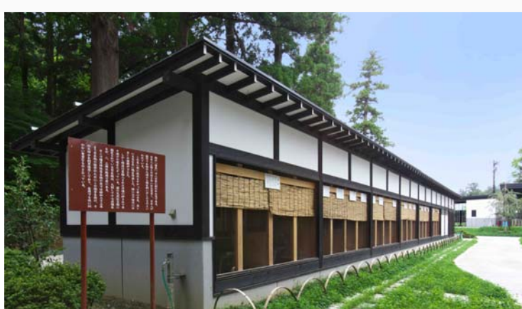
【日本鶏舎棟】 展示室22室を備えた、全長約30mの建屋
