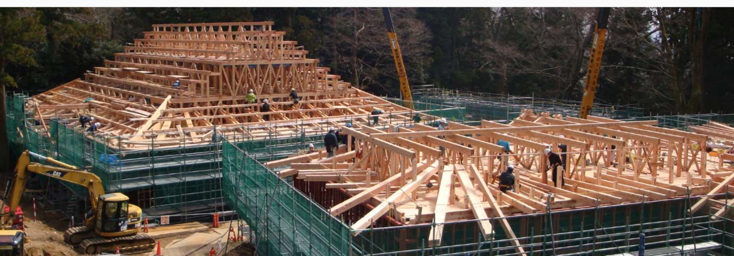
【弓道場（奥）・みずほ館（手前）】 小屋組を木造、下部を鉄骨造とした混構造
